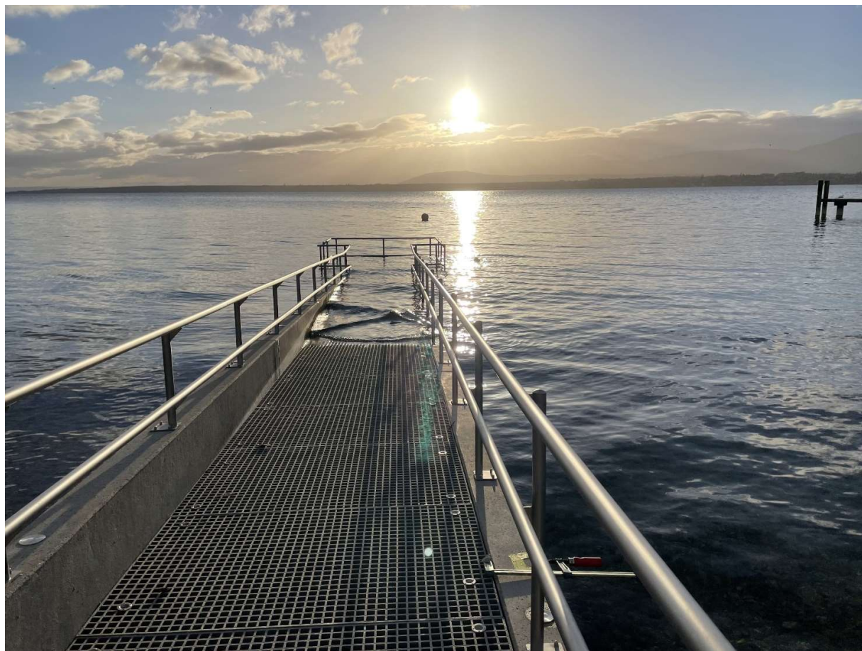
Rampe de la plage des Port-Choiseul, Versoix
